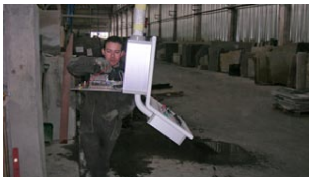
Montaż panelu sterującego
